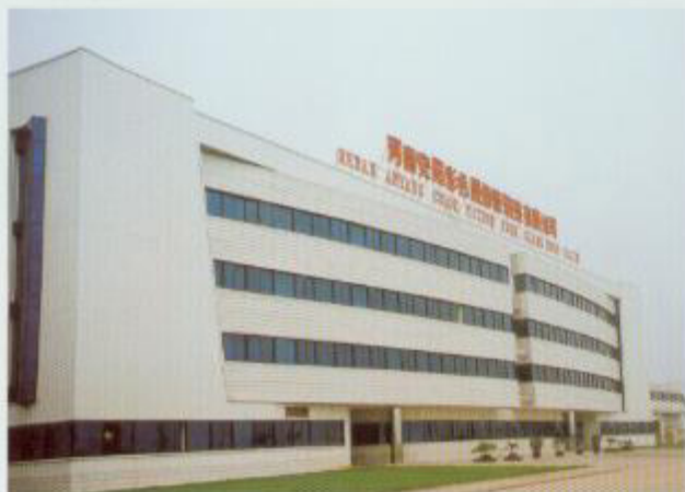
• 河南安阳彩色显像管厂房 Anyang Colour Picture Tube Glass Bulb, Henan
