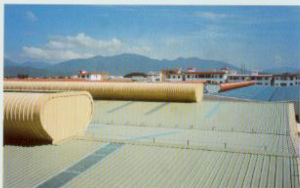
• 深圳震雄工业园厂房 Zhenxiang Industrial Zone, Shenzhen
