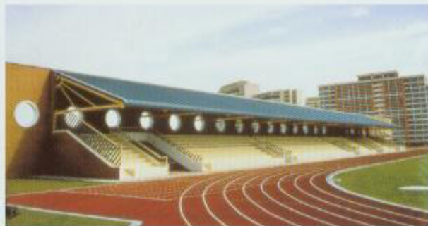
• 新加坡体育场 Tampines Sports Stadium, Singapore
