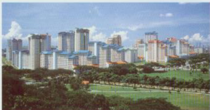
• 新加坡住宅群 Brishon Housing Estate, Singapore
