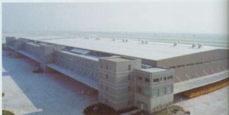
• 上海浦东国际机场货运库 Pudong International Airport Cargo Centre, Shanghai
