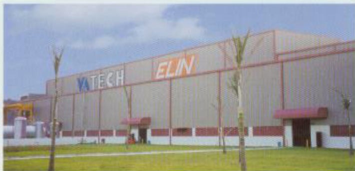
• 广州依林变压器厂 Elin Transformer Co., Guangzhou
